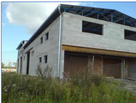
Obrázek 2 - Realizace průmyslový objekt 1
